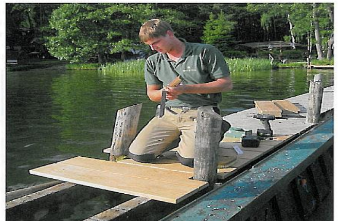
Auch Steganlagen lassen sich ohne Tropenholz erneuern
